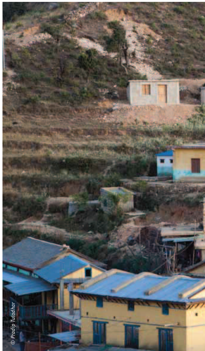
In de regio Kubinde staat op veel daken een regenwatersysteem
