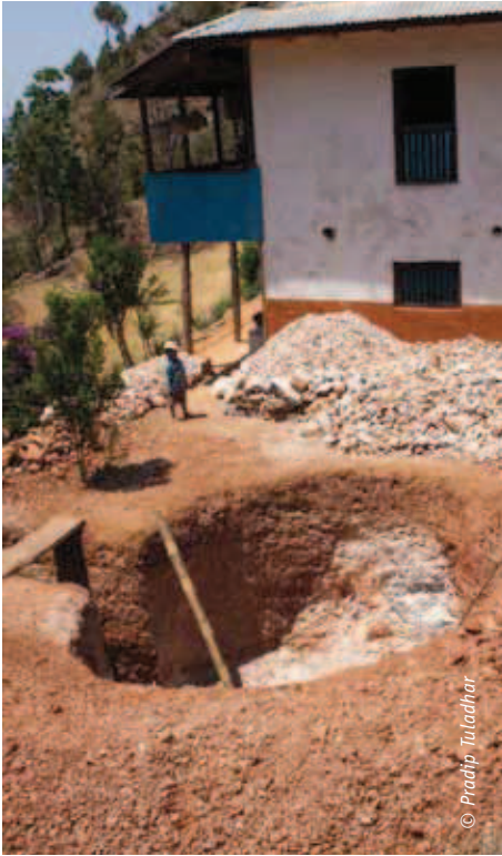
Een regenwatersysteem in aanleg
